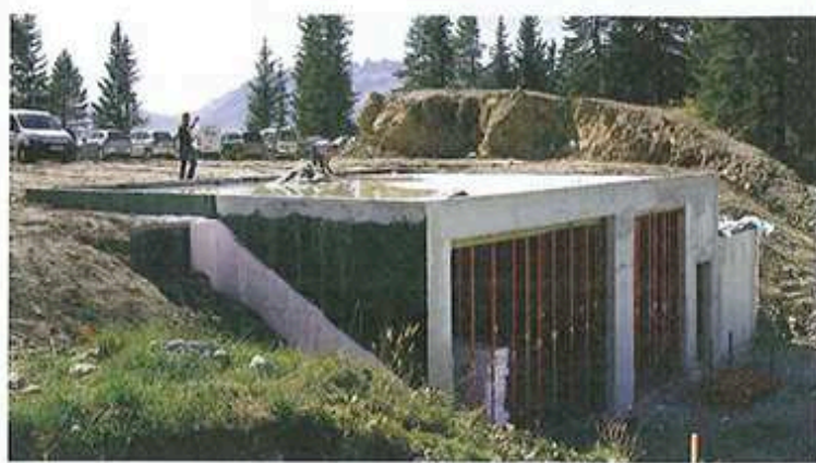
Au Tovet, la construction du bâtiment technique est en cours.
